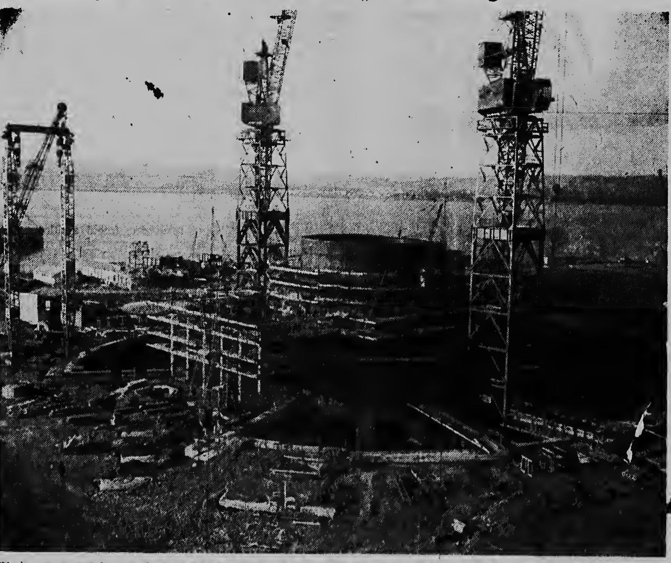
Dit is een overzicht van de in aanbouw zijnde door kernenergie aangedreven elektrische centrale in Berkeley in Engeland. De grote „pillendoos” in het midden van de foto is een van de twee kernreactoren; de eerste is bijna gereed, de tweede wordt men een half jaar later gereed te hebben. De bouwkosten van de centrale bedragen (tussen de 300 en 400 miljoen gulden; wanneer de centrale in bedrijf is — men verwacht dat dit in 1960-1 zal zijn — heeft zij een capaciteit van 275000 kilowatt.
